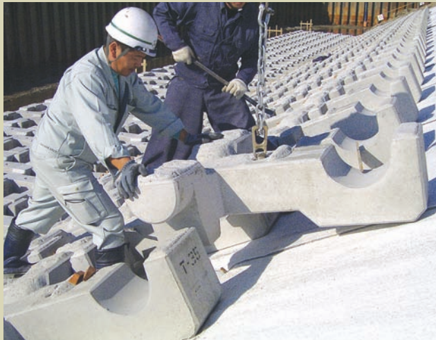
ブロックを単体で施工します。
