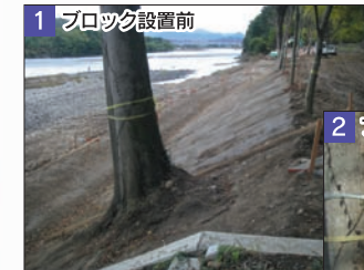
1 ブロック設置前
