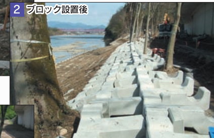
2 ブロック設置後
